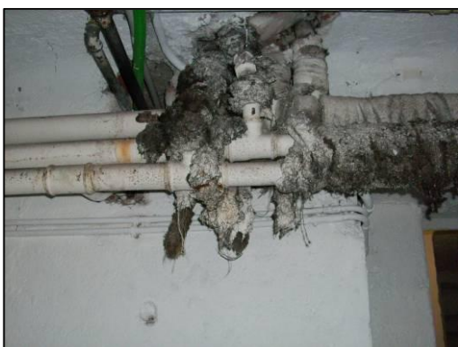
Ospedale Macedonio Melloni Cantina villetta Allegría - Rivestimento tubazioni
